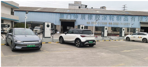
厦门西柯充电站
